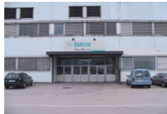
Iskra MIS - Ljubljana ( Fire Alarm, AC )
