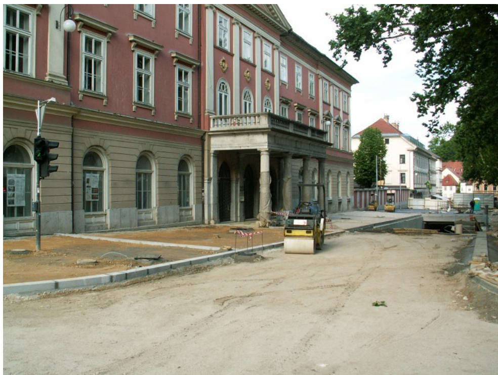
Lokacija, stavba Kazine, kjer naj se zariše večje število brezplačnih parkirnih mest za motorna kolesa.
